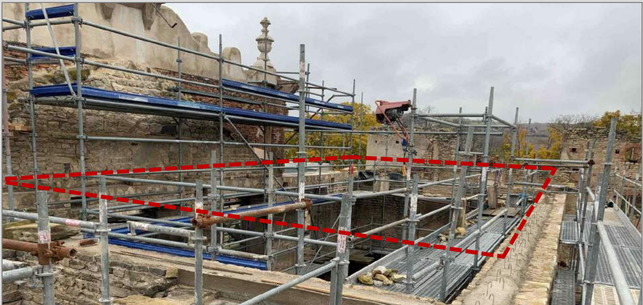
vue inversée de celles-ci-dessus : le chaînage ceinture toute la superficie de l'escalier d'honneur
