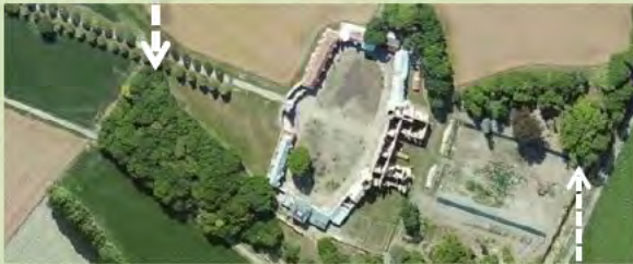
localisation du muret et de l'escalier
