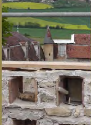
reconstruction des arases de murs, des derniers rangs de boulins et chaînage final
