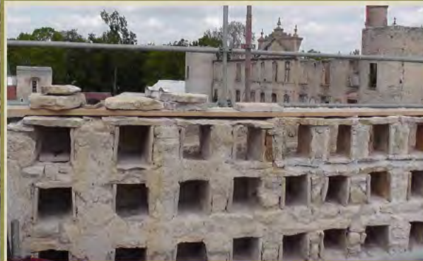
reconstruction des arases de murs, des derniers rangs de boulins et chaînage final
