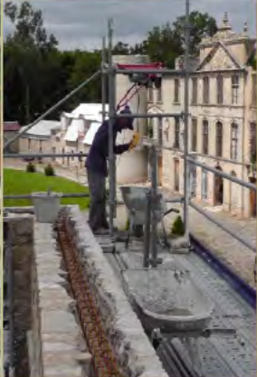
reconstruction des arases de murs, des derniers rangs de boulins et chaînage final
