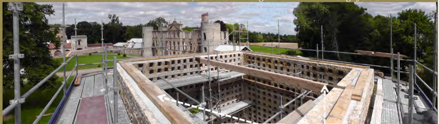
vue panoramique de la pose des pannes sablières et d'un entrail
