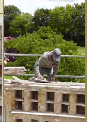
reconstruction des arases de murs, des derniers rangs de boulins et chaînage final
