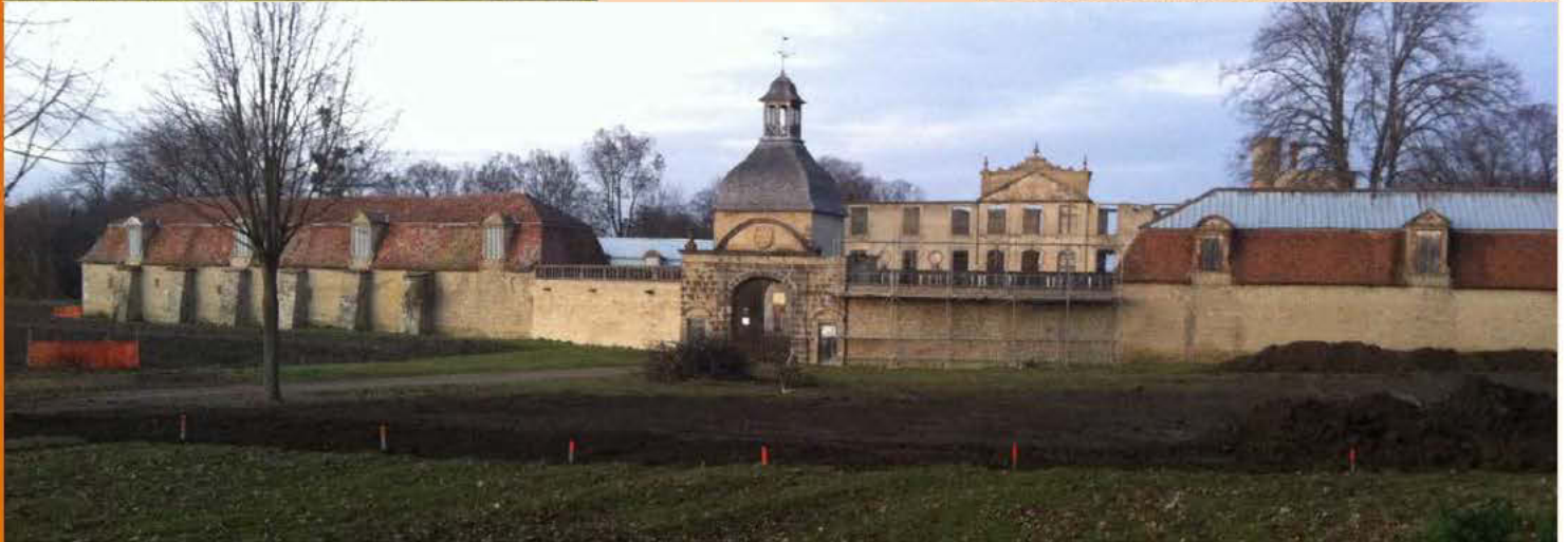
janvier 2012 : vue générale sud au début du terrassement de part et d'autre de l'allée (suite et fin : lettre n°9)
