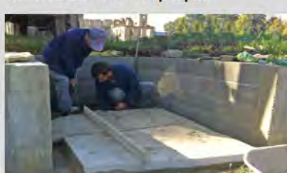
pose des Seuils
