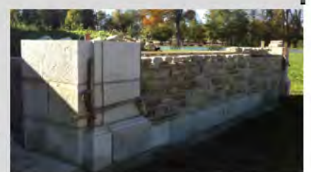
pose des piliers.
