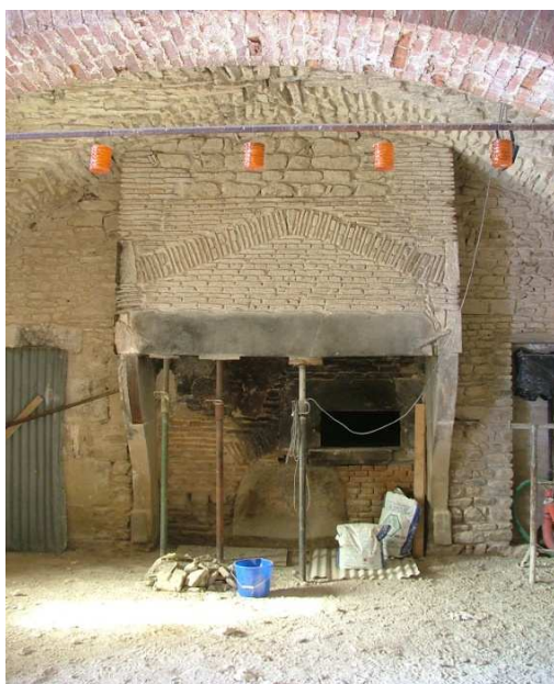
vue des cuisines après piquetage
